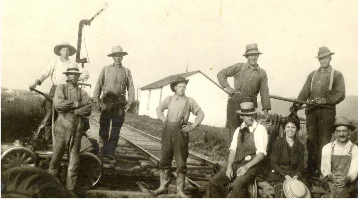
Groupe travaillant à la construction du chemin de fer, vers 1900.
