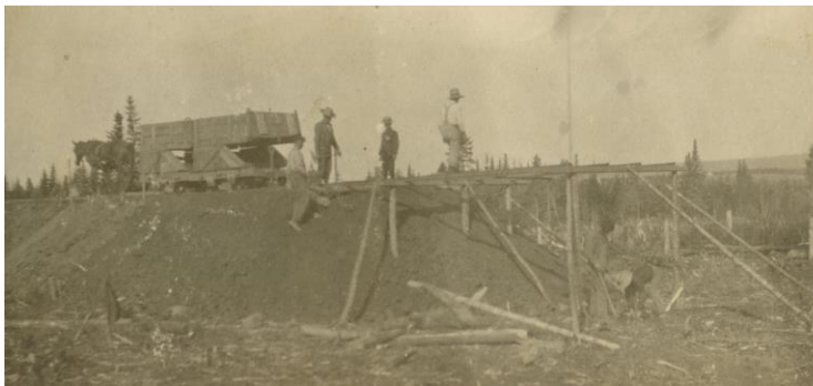
Construction d'un tronçon du chemin de fer, 1905.
